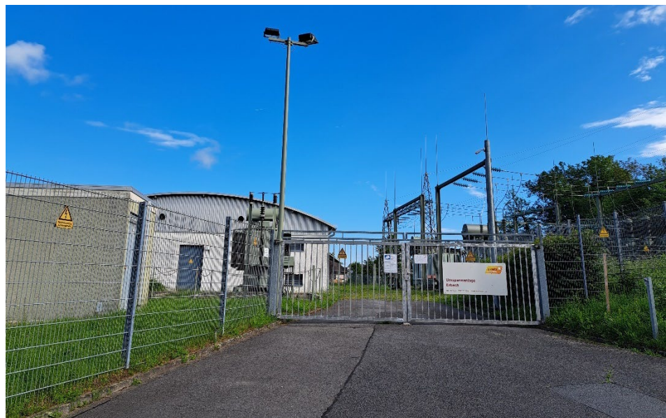
Abbildung 3: Zufahrt zur Umspannanlage Erbach
